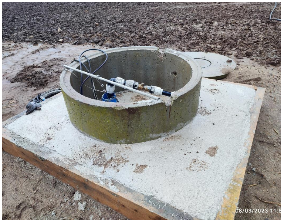
Vue sur le forage
