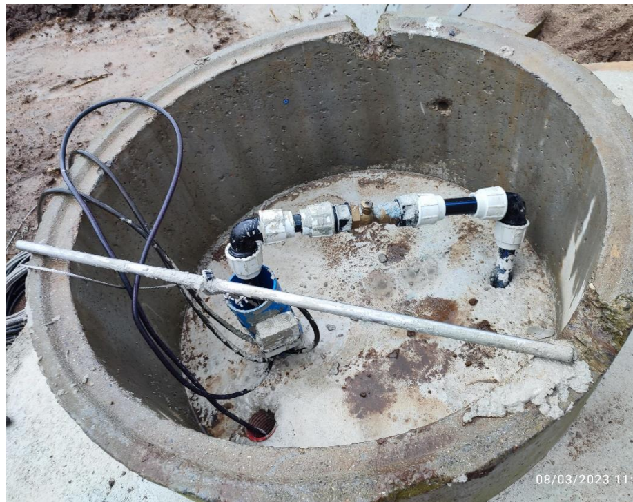
Vue sur l'intérieur du citerneau du forage
